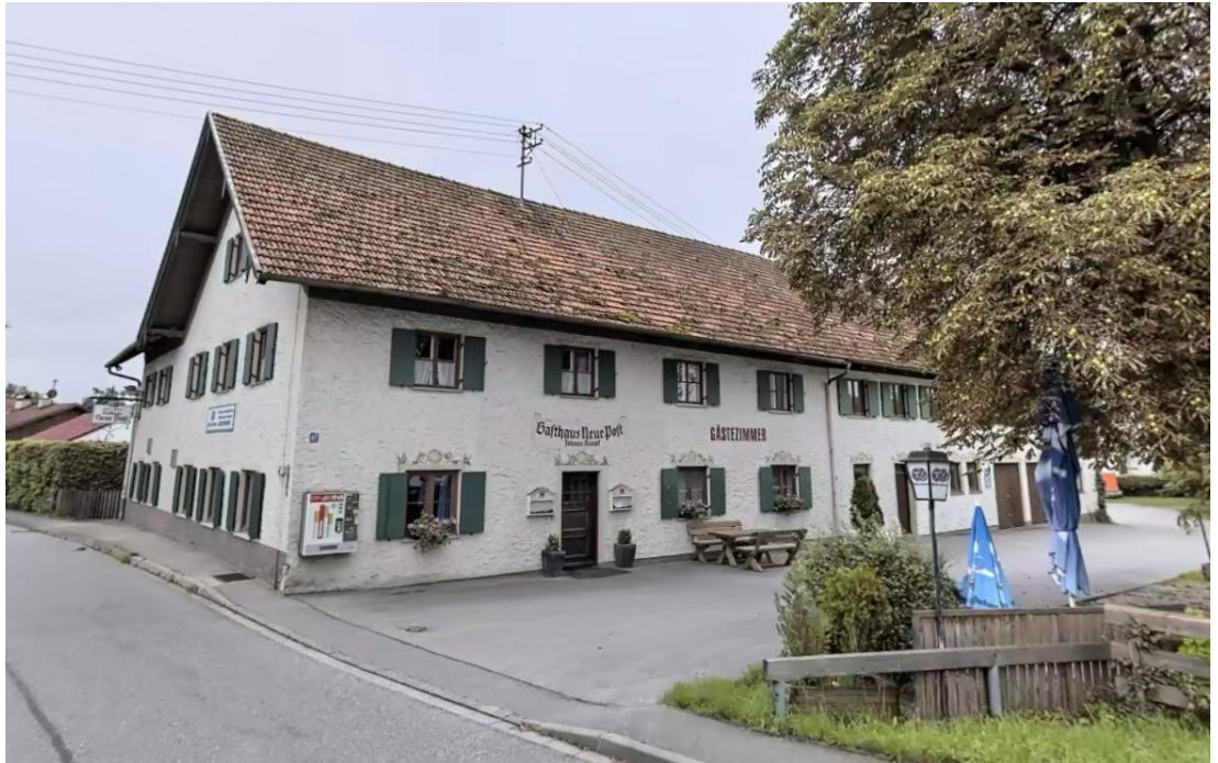
Abb. 2 Blick auf die Nordseite des Bestandsgebäudes auf Fl. Nr. 251, Quelle: Apple Karten, Stand Februar 2026
